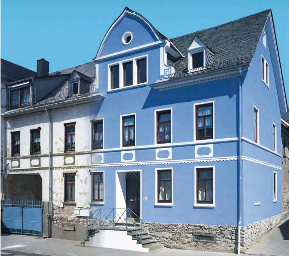
*Tragfähige Altputzflächen können mit einem geeigneten Putz überarbeitet werden.*
