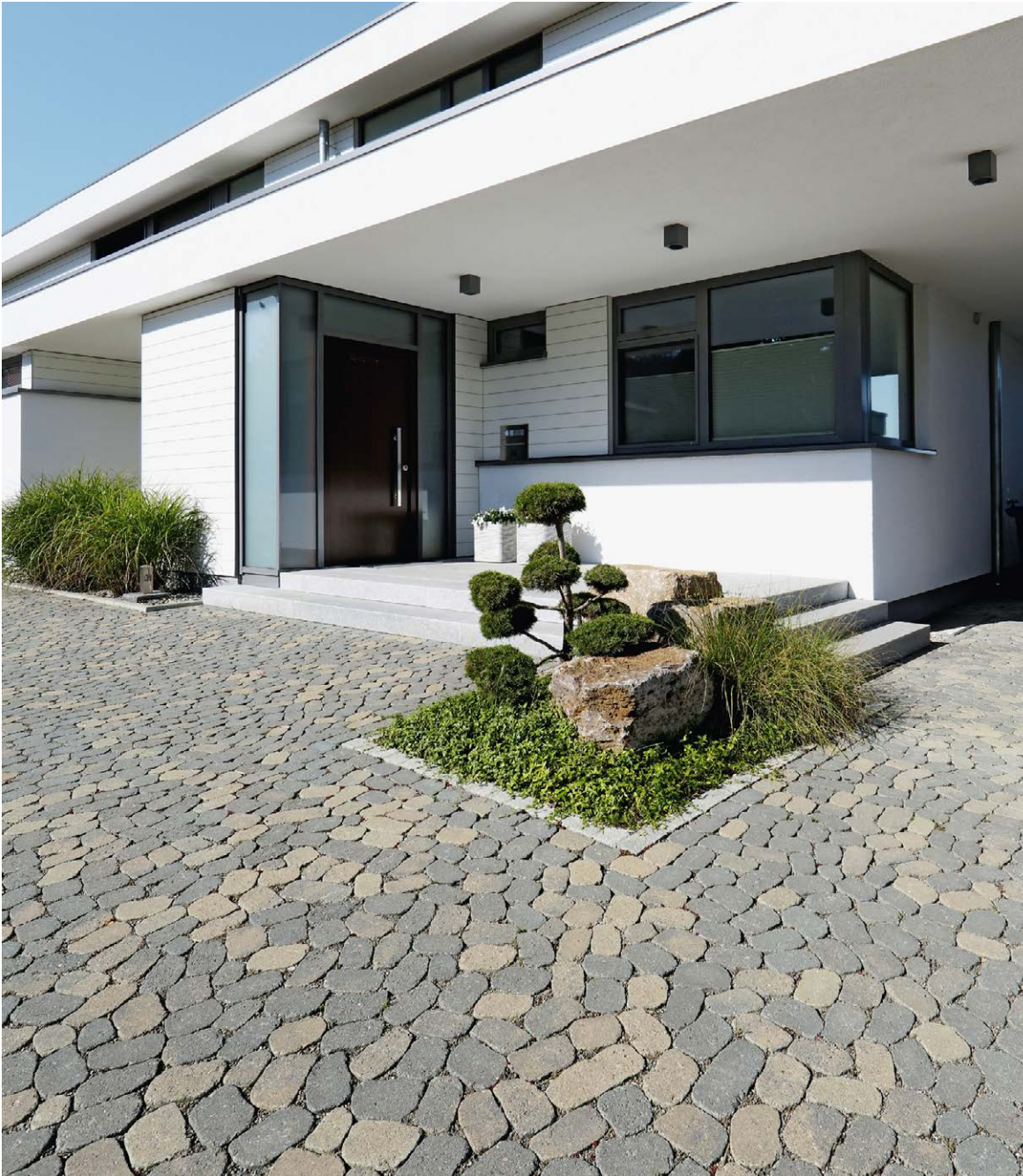
Die stark horizontal gegliederte Fassade trifft auf die richtungslose Verlegung der ARENA®-Steine auf dem Boden.
